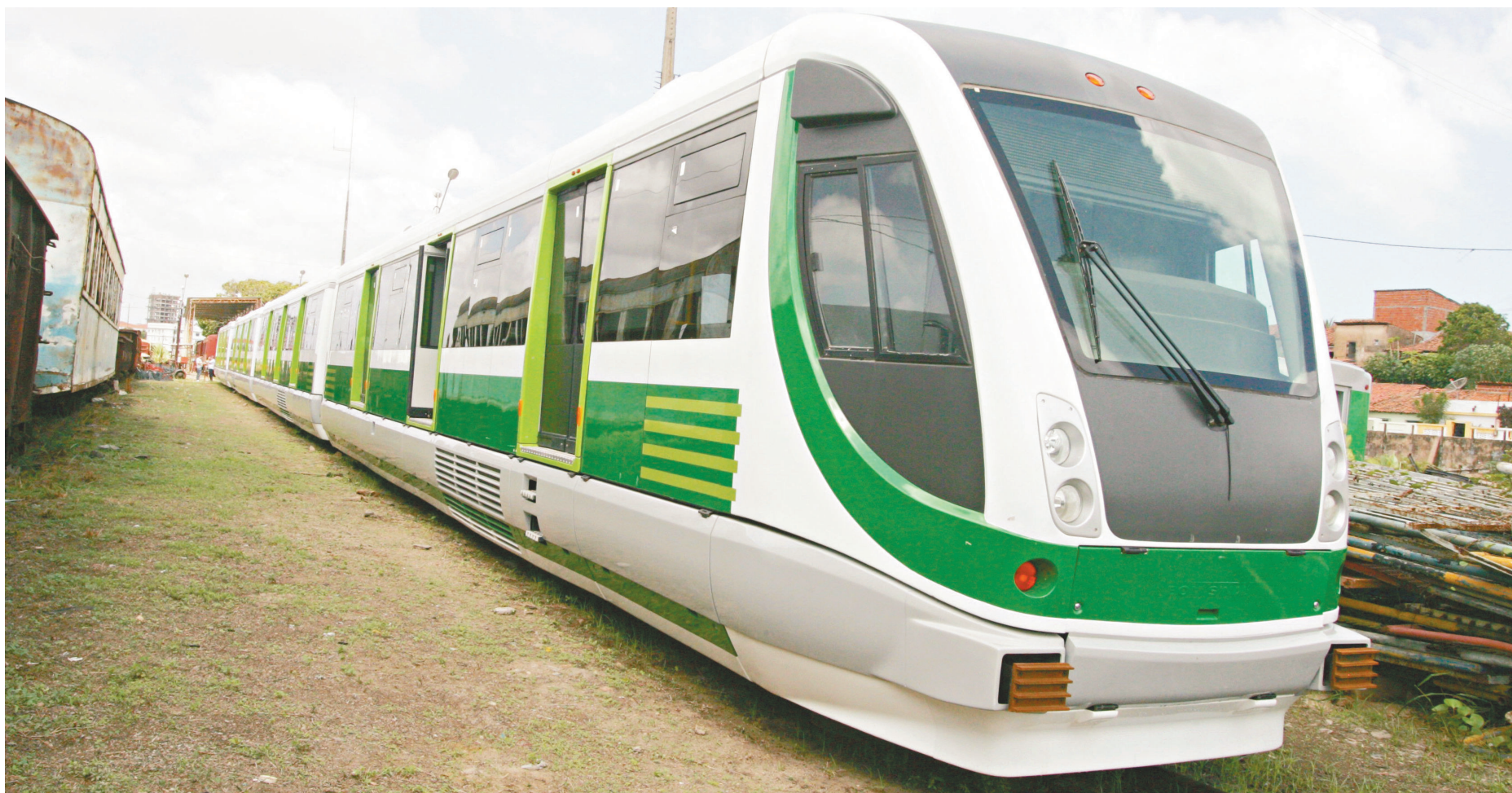
Obras para a construção do Veículo Leve sobre Trilhos (VLT) que ligará Parangaba ao Mucuripe têm prazo de conclusão previsto para antes da Copa de 2014. FOTO: JOSÉ LEOMAR
