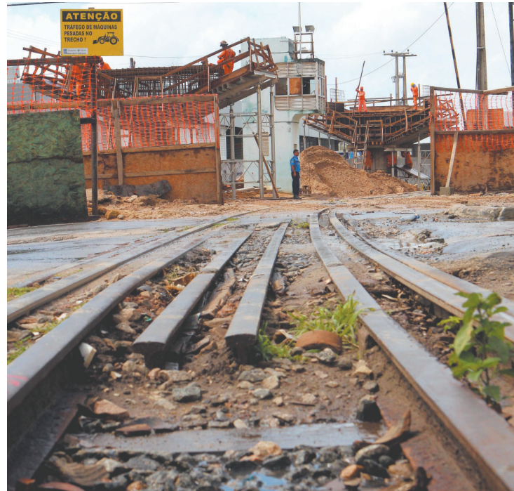
Das dez estações previstas, uma segue, no entanto, com trabalhos avançados. É o ponto da Vila União, na Avenida Borges de Melo. FOTO: J.L. ROSA
