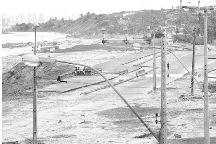
POR ENQUANTO, as obras ainda permanecem paradas, mas há promessas para retomá-las este ano FOTO: JOSÉ LEOMAR
